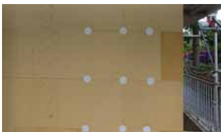
Fig. 6 PAVAWALL-BLOC : montage terminé
