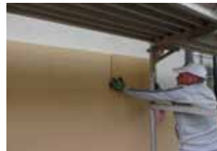
Abb. 3 Positionierung durch Heranschieben für beste adhäsive Anfangshaftung
