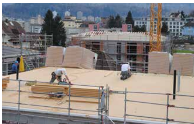
Ausgezeichneter Hitzeschutz im Sommer und umfassender Wärmeschutz im Winter.
