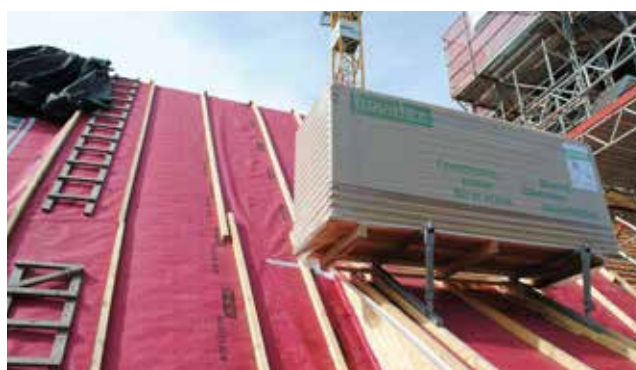
Flächendeckende Verlegung mit der PAVATEX ADB Bahn.
