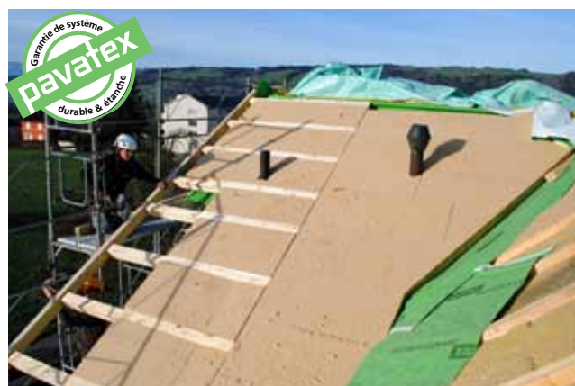
La pose en surface du lé d'étanchéité à l'air, sur les chevrons, pour une couverture de toit sûre et durable.
