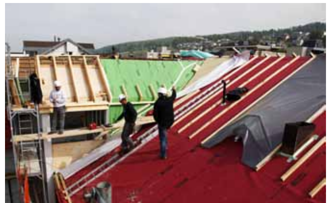
Die Unterdachbahn PAVATEX ADB schützt das Dach zuverlässig vor Witterungseinflüssen.
