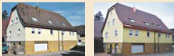
La rénovation de la bâtisse historique en bois a été entièrement réalisée avec le système de rénovation de toiture PAVATEX.
