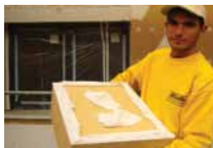
Fig. 2 Collage par points et sur les bords
