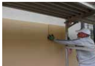
Abb. 3 Positionierung durch Heranschieben für beste adhäsive Anfangshaftung
