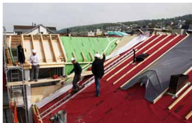
Le lé de sous-couverture PAVATEX ADB protège efficacement le toit contre les intempéries.
