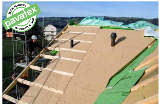
Die flächige Verlegung der LDB Luftdichtbahn über dem Sparren für ein sicheres und dauerhaftes Dach.
