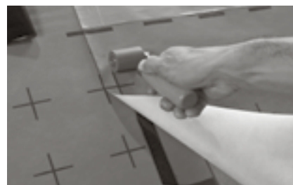
L'une des nouvelles solutions de systèmes : La bande PAVATAPE assure l'étanchéité de PAVATEX ADB sur des panneaux de sous-toiture ISOLAIR / ISOROOF, PAVATHERM-PLUS+ ou PAVATHERM.
