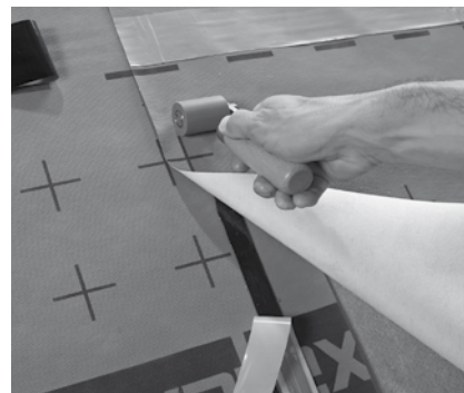
Eine der neuen Systemlösungen: Die PAVATEX ADB auf ISOLAIR / ISOROOF Unterdeckplatten, PAVATHERM-PLUS + oder PAVATHERM Dämmelementen, abgedichtet mit PAVATAPE.
