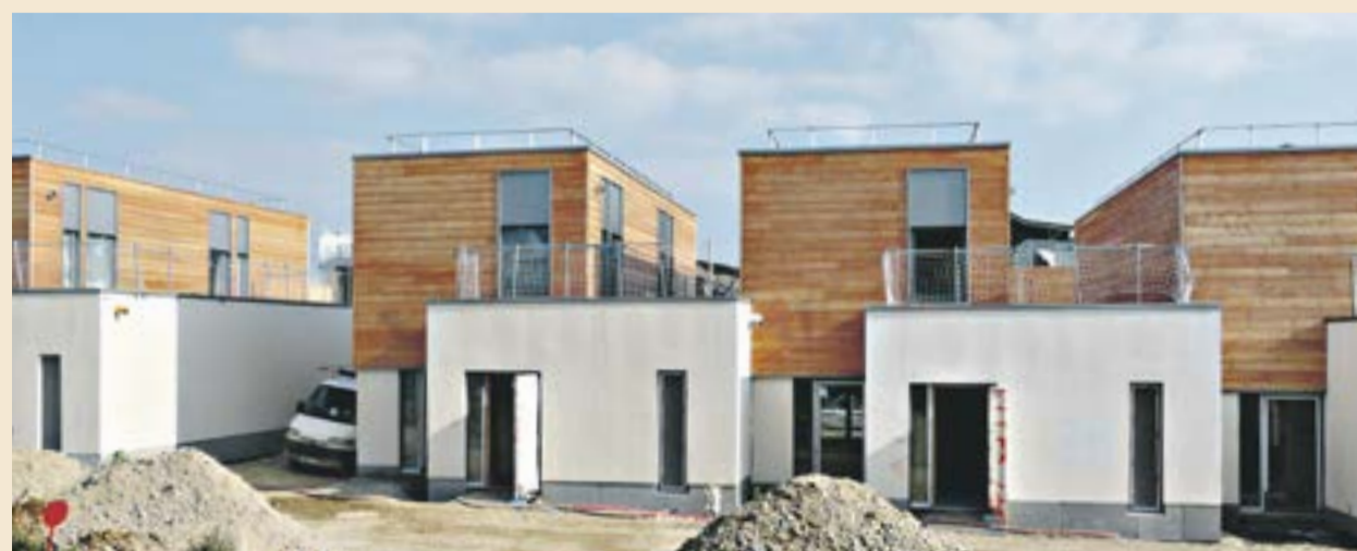
PAVATEX DIFFUTHERM und PAVATHERM bilden die Basis der Fassaden.
