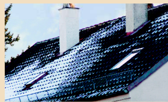
Über ein unzureichend gedämmtes Dach entweicht im Winter kostbare Wärme nach aussen. Erkennbar dadurch, dass der Schnee auf dem Dach schmilzt.
