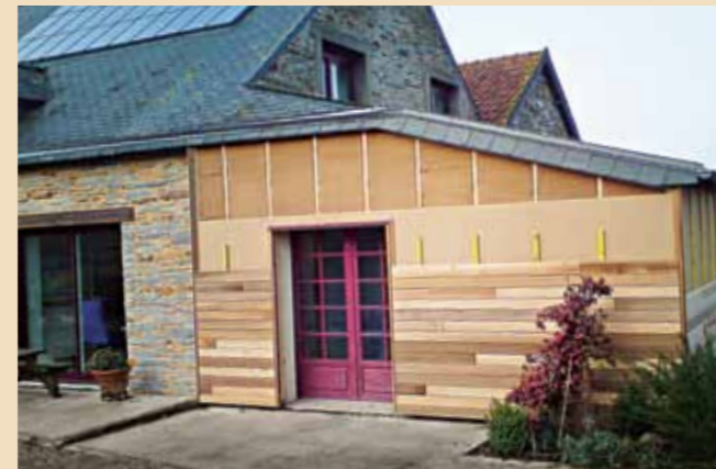
Die Aussenwanddämmung mit ISOLAIR-Dämmplatten sorgt auch bei rauen Wetterbedingungen wie in der Bretagne für umfassenden Wärmeschutz.
