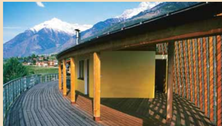
Bei diesem Wohnhaus in Meran (I.) sorgt die Wand- und Dachdämmung dafür, dass die Hitze im Sommer draussen bleibt.
