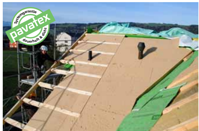
Die flächige Verlegung der PAVATEX LDB 0.02 Luftdichtbahn über dem Sparren für ein sicheres und dauerhaftes Dach.
